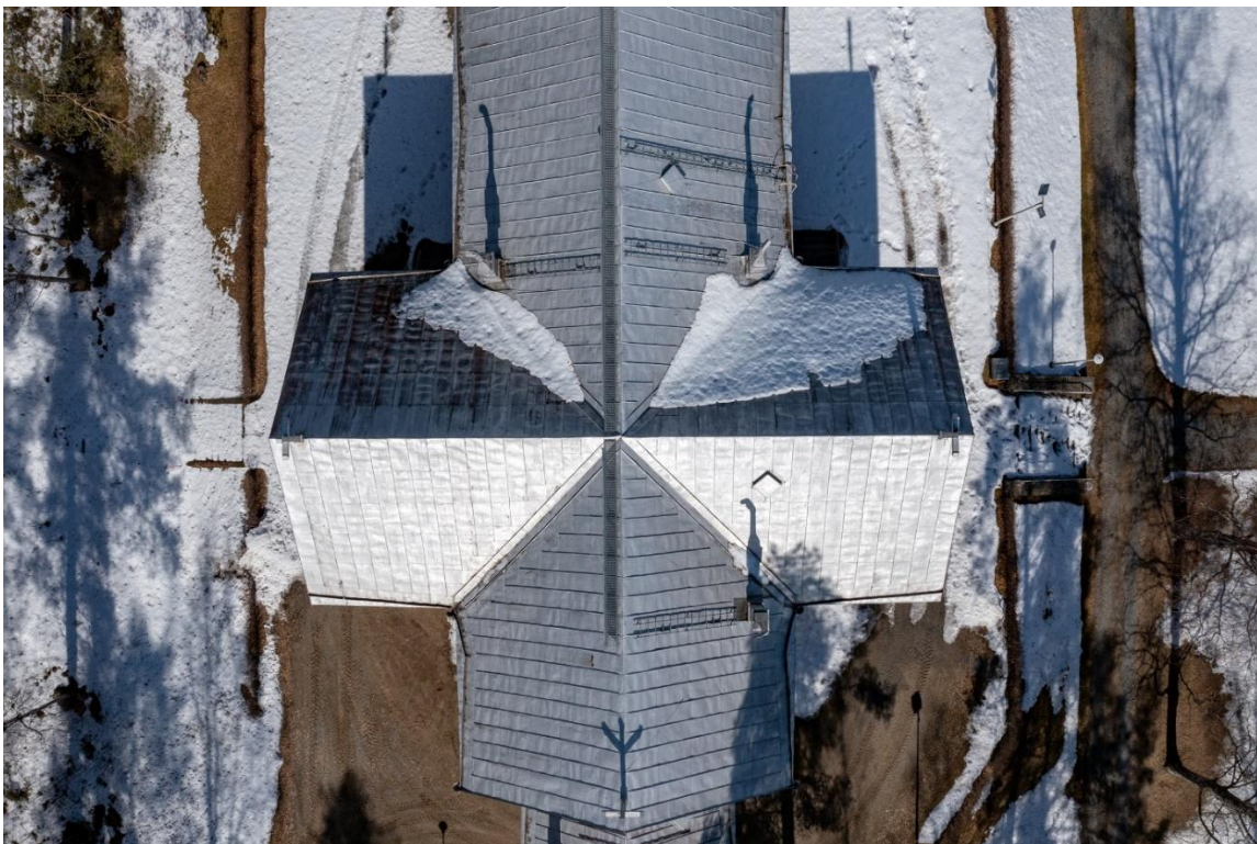
Kuusjärven kirkon kattoa ylhäältäpäin
