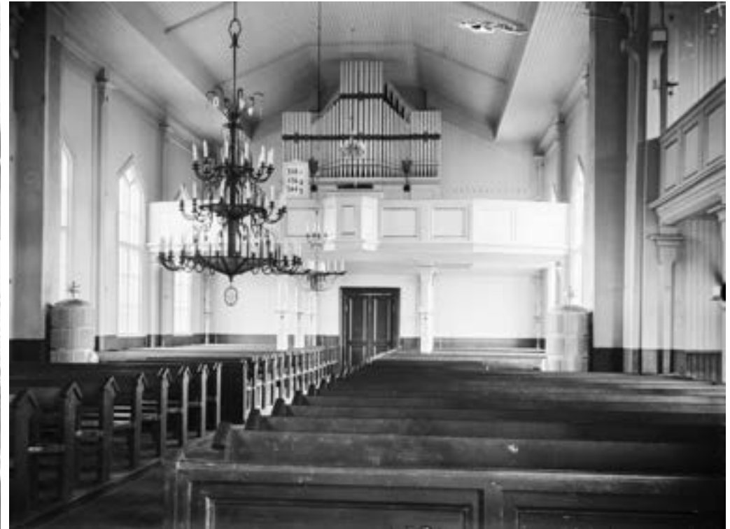
Kuva vuodelta 1931, jolloin peruskorjauksen toimenpiteet oli saatu valmiiksi. Kuva: Museoviraston kuvakokoelma.
