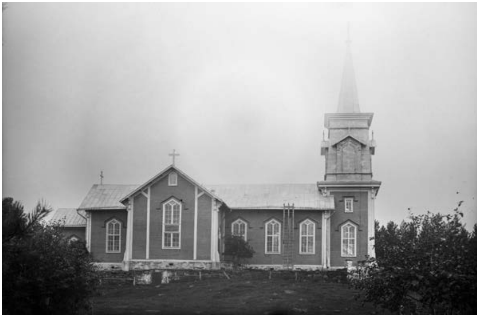
Kuusjärven kirkko vuonna 1926. Kirkon kivijalka oli korkea ja rakennuksen itäpuolen perustusrakenteeseen oli sijoitettu viinikellari. Kirkon ympärillä kulkenut kivimuuri myötäili rakennuksen itäpuolella kirkon kivijalkaa. Museoviraston kuvakokoelmat.
