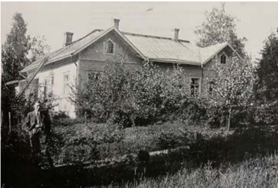
Pappilan päärakennus kuvattuna puutarhan puolelta. Kuva Taipale, Kuusjärven pappilan vaiheita.
